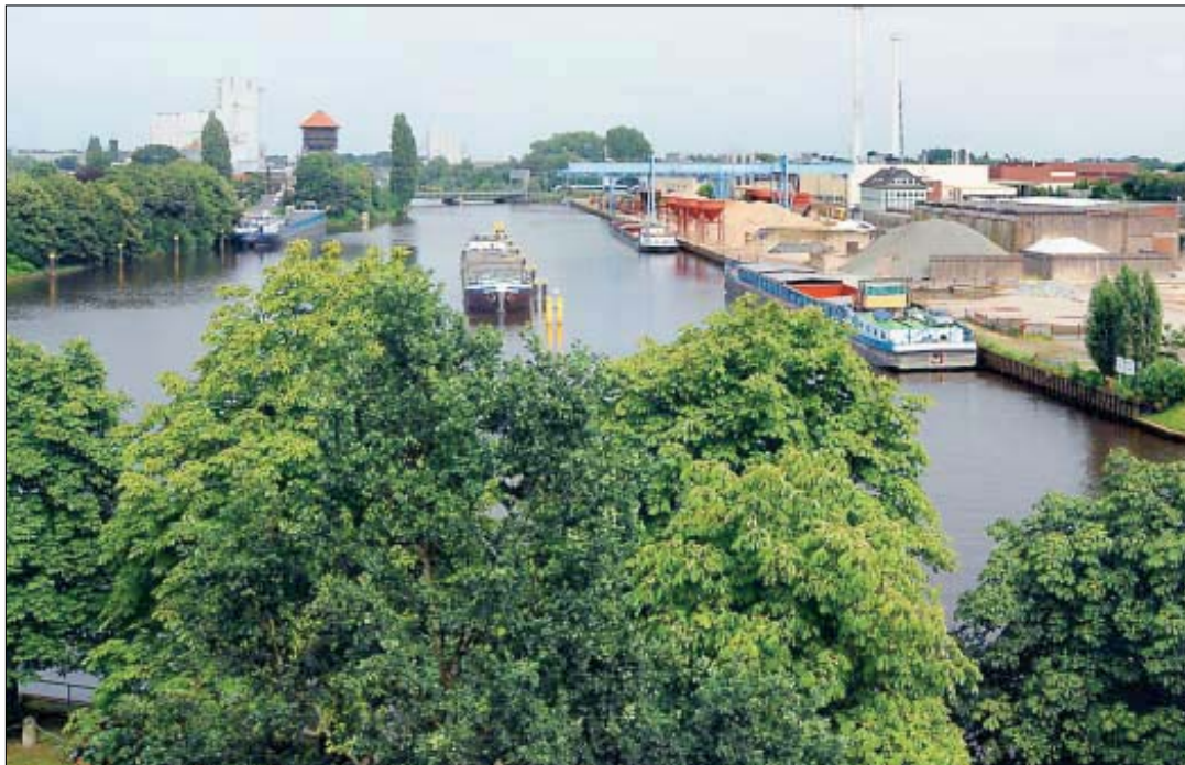
Wohnen neben Schiffen: Auf dem Grundstück von Rhein-Umschlag (rechts) sollen einst Häuser stehen. Auf der anderen Seite soll sich derweil der Hafepark entwickeln.
